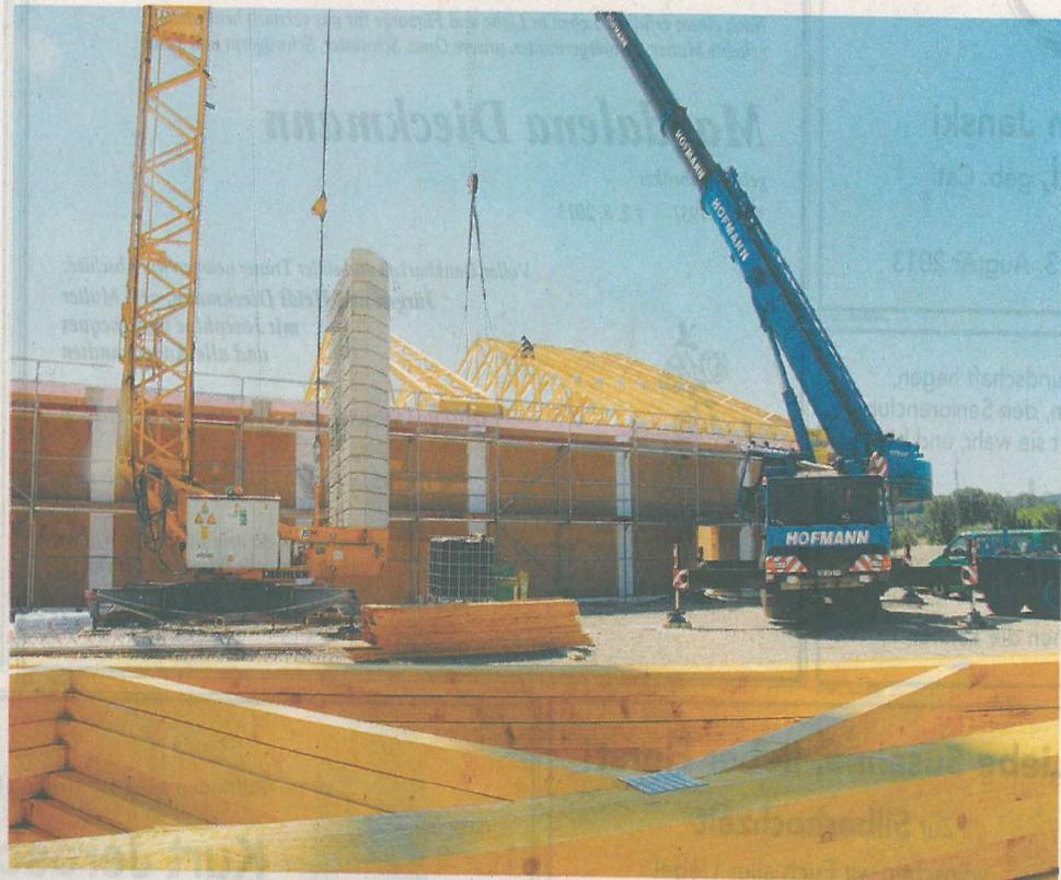
**Viel Holz vor dem neuen Markt:** Nach dem Zusammenbau der Balken bugsiert ein Spezialkran die Elemente an die Stelle, wo sie zur Dachkonstruktion des Vollversorgers zusammengefügt werden.
